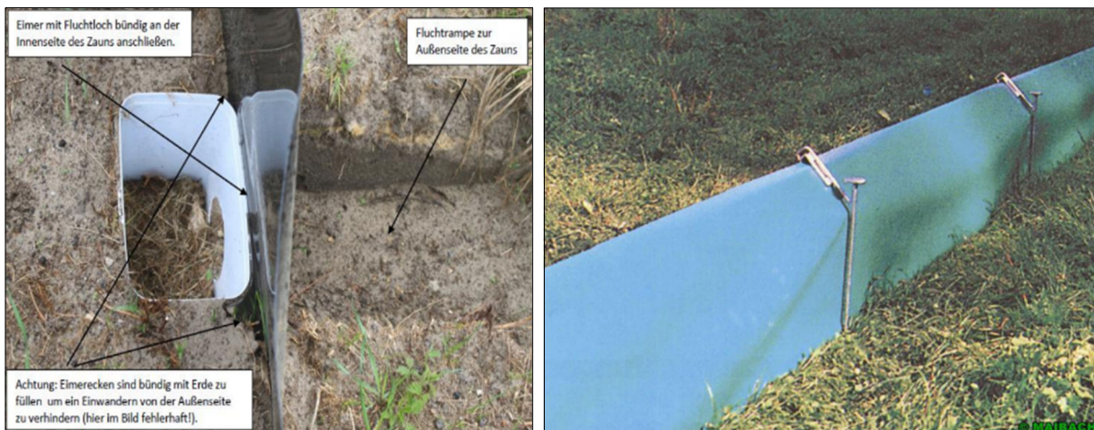
Abb. 14 Beispiele für die ordnungsgemäße Installation eines Reptilienschutzzauns
